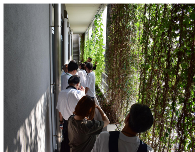
壁面ルーバー/壁面緑化
