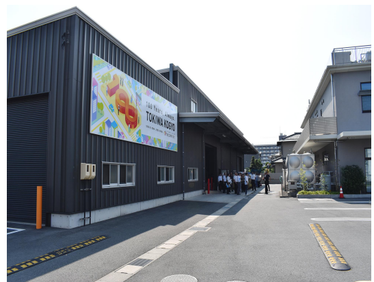
井水受水槽廻り
